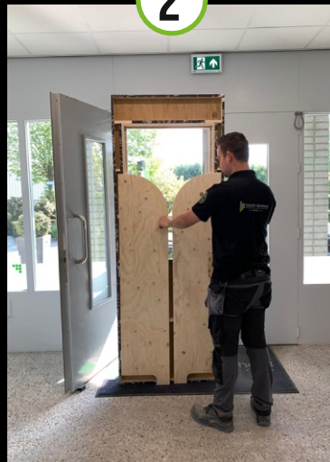
UNIT VOOR DEUROPENING PLAATSEN
