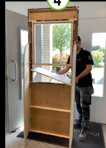
AFLEG BOARD PLAATSEN
